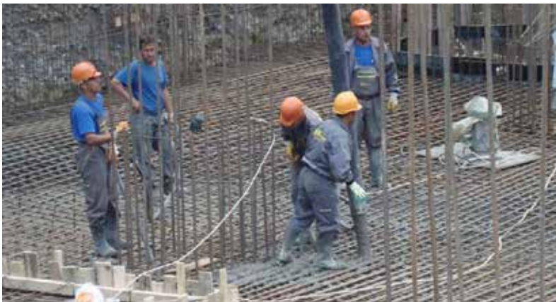
Betoniranje masivne temeljne ploče – FLUIDING M
