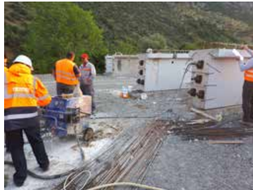
Injektiranje kablova za prethodno naprezanje
