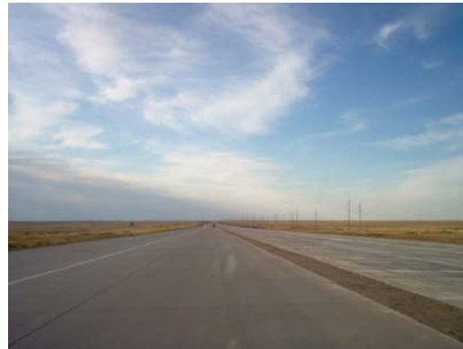
Слика 6.: коловозот непосредно пред пуштање во експлоатација
