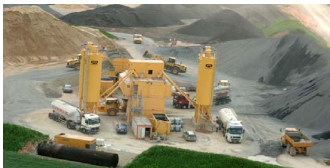
Слика 1: фабрика за бетон
