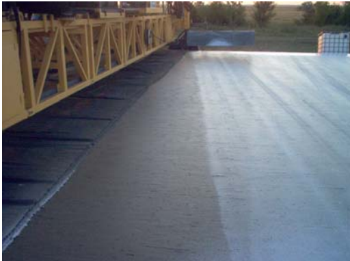
Слика 5.: изглед на завршната бетонска површина и проце на заштита на свежата бетонска маса
