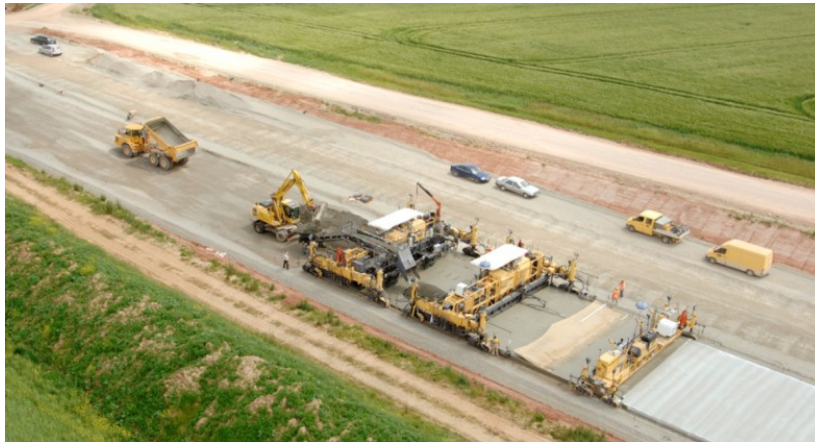
Слика 2. комплекс на машини за вградување на бетонот на самата траса
