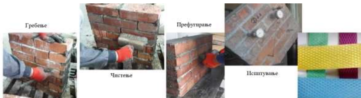
Сл. 3. Зајакнување со конструктивно префугирање
