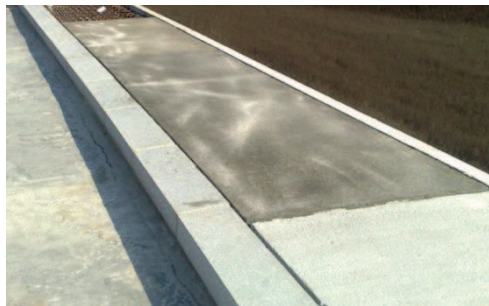
Obrada pešačke staze na mostu – sistem na bazi epoksida i metakrilata
