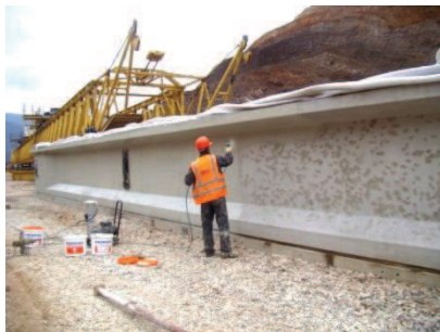
Zaštita mostovskog nosača oblaganjem - coating (Antikorozin-BB)
