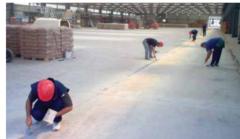
Цементарница „Холцим“ - Србија (исполна на работни фуги со акрилатен еластичен кит)
