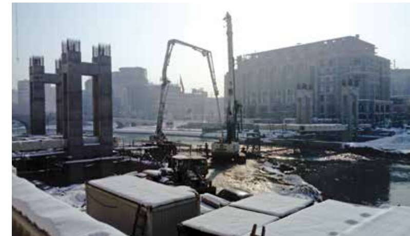
Зимско бетонирање во корито на р.Вардар, Скопје
