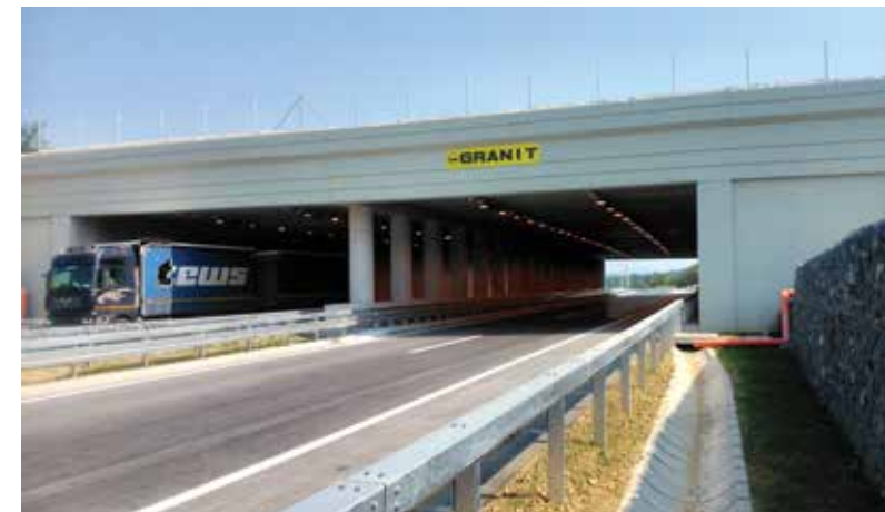
Тунел Cut & Cover на автопатот Прњавор – Добој, БиХ
