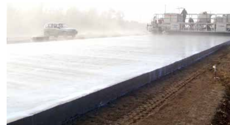
Меѓународен коридор „Западна Европа - Западна Кина (Шимкент)“ - Казахстан (заштита на свеж бетон)
