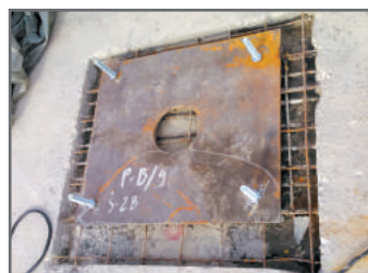
Процес на заливане на анкери
